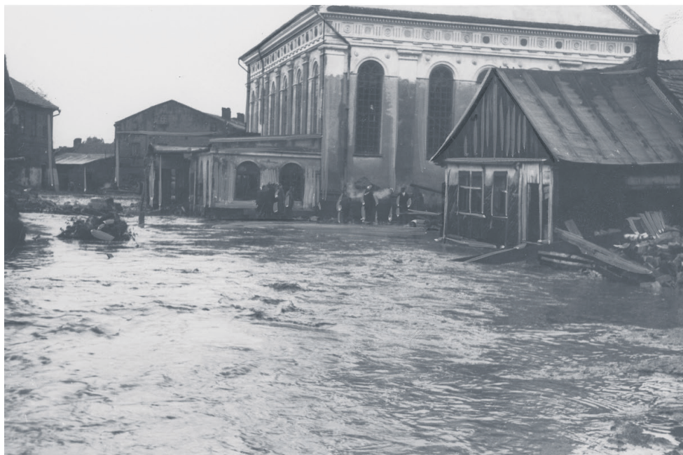
Zniszczenia Działoszycc na Zastawiu. Widoczna zalana, przez wezbrane wody Nidzicy, synagoga. [Ze zbiorów NAC]
